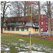
Die Dachwohnung im ehemaligen Kosthaus wird zu einem Kindergarten umgebaut. Foto: Marc Dalstein
