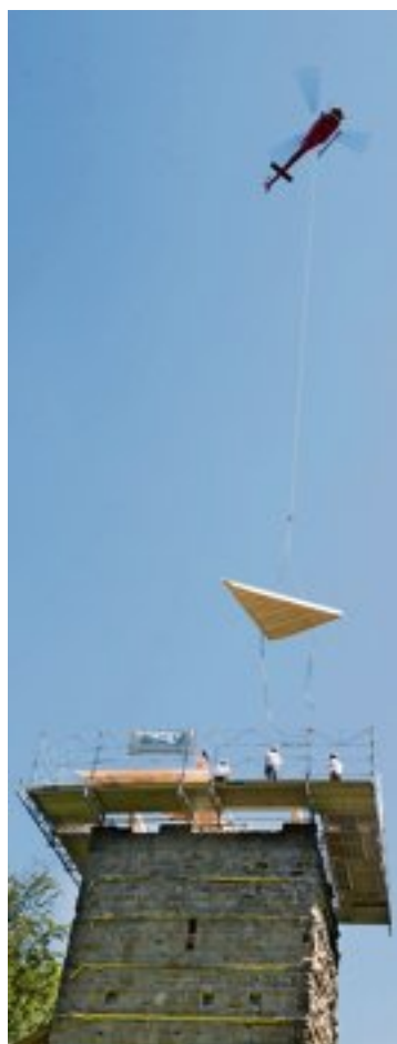
Acht Helikopterflüge waren nötig, allein um die einzelnen Dachelemente zu montieren. Nun wird das neue Holzdach isoliert und mit Kies bedeckt.
