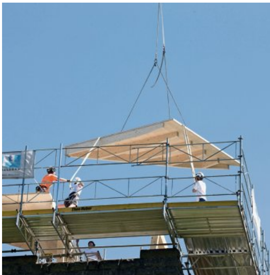
Acht Helikopterflüge waren nötig, allein um die einzelnen Dachelemente zu montieren. Nun wird das neue Holzdach isoliert und mit Kies bedeckt.
